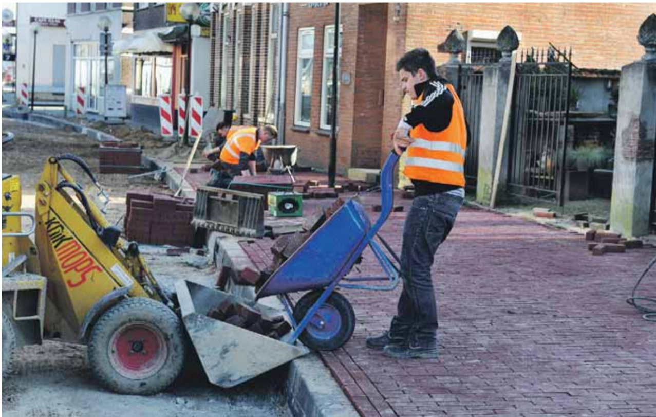
De werkzaamheden bij het kruispunt F.B. Deurvorststraat en de waterstraat.
